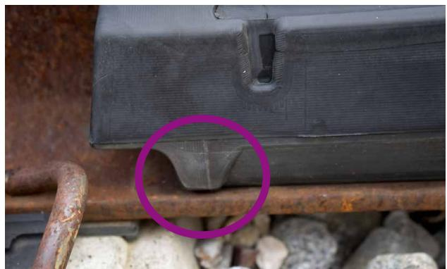
Die korrekte Einbaulage des Dämpfers ist dann erreicht, wenn der Indikator (siehe Kreis) vertikal bündig mit der Schienenfußkante abschließt.
