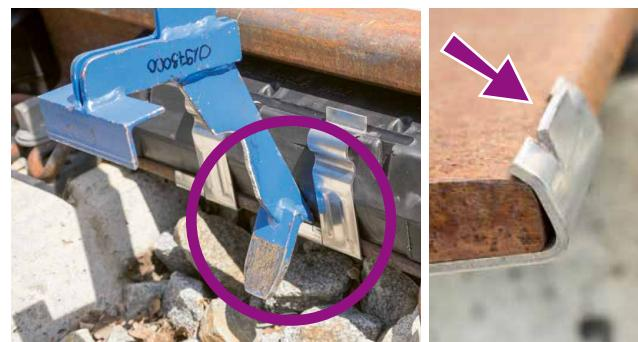
Die Klammer wird mit der Rückseite des Montagewerkzeuges nach unten gedrückt und rastet aus.
