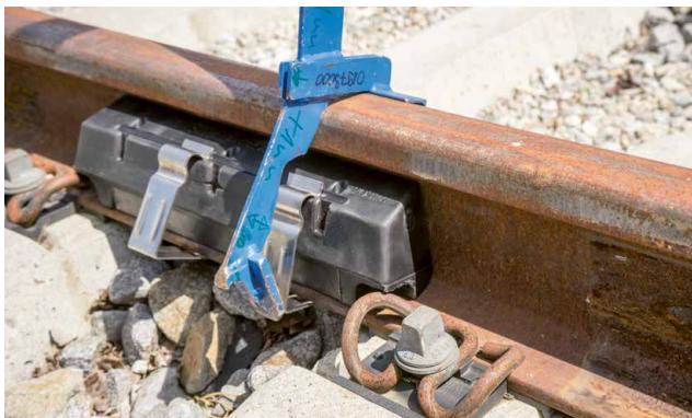
Im Anschluss werden die Klemmen mit dem am Schienenkopf arretierten Einbauhebel unter dem Schienenfuß **ruckartig** durchgedrückt und in die Endposition gebracht. Die Endposition wird durch ein „klick“-Geräusch signalisiert.
