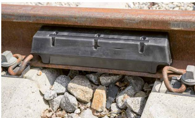
Die **STRAILastic\_A INOX 2.0** Dämpfer möglichst in der Mitte des Schwellenfaches in die Schienenkammer einlegen und durch links-rechts Bewegungen festdrücken. Somit haben Schienesteg und Schienenfuß vollflächigen Kontakt.
