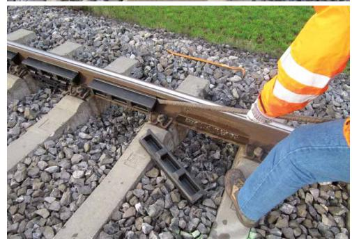
Das **STRAILastic\_A synth** Dämpfer lässt sich leicht mit einer handelsüblichen Brechstange aushebeln.
