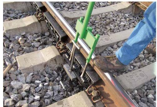
Den **STRAILastic\_A synth** Spreizdorn in die dafür vorgesehenen Öffnungen mit kräftigen Hammerschlägen in die Klemme einschlagen
