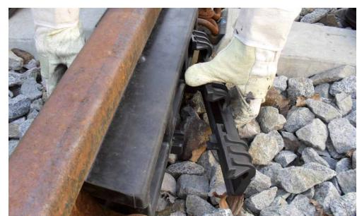
Mit der **STRAILastic\_A Einbaumaschine** (mit speziell montierbarem **STRAILastic\_A synth** Aufsatz) werden die Klemmen im Schwellenfach festgedrückt, sodass die Klemmen in Endposition einrasten.
