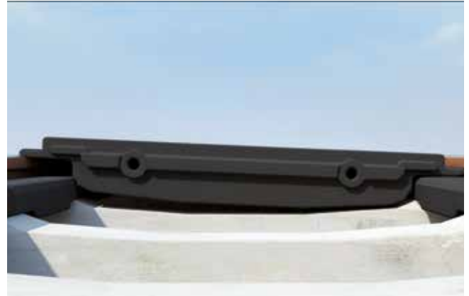
STRAIL® Innenplatte auf einer Seite mit der Lippe unter den Schienenkopf einlegen und auf der anderen Seite die Lippe mit Montagepaste einstreichen.
