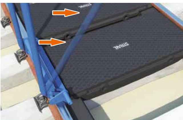
Den Plattenrand mit dem Einbauhebel zusammendrücken bis die Lippe unter den Schienenkopf rutscht.
