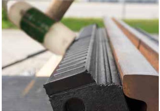
KFE schräg ansetzen. Beim Einschlagen verkeilen sich die Haltelippen der KFE unter dem Schienenkopf und fixieren somit das Element in der Schienenkammer.
