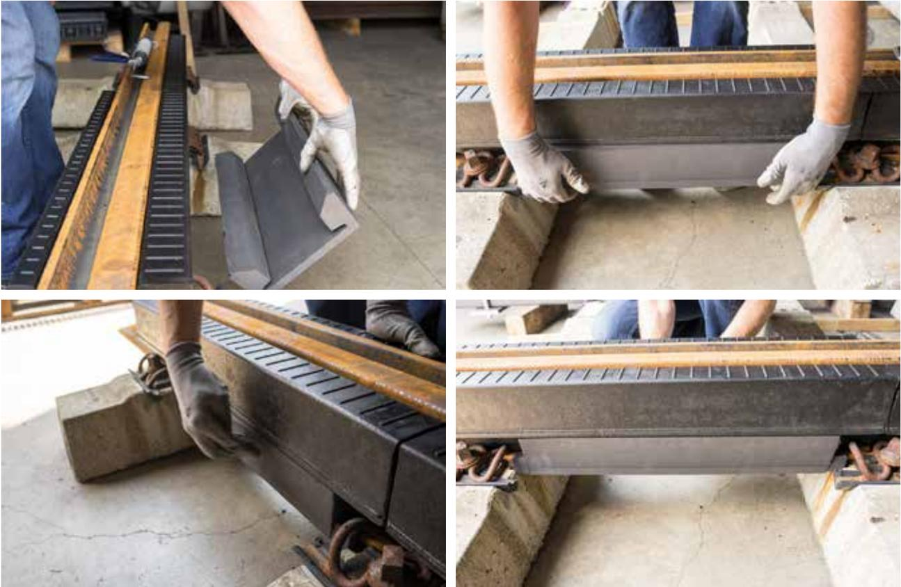
Am Ende wird das Schienenfußprofil unter die Nase des KFE gedrückt und rastet dadurch ein. Die KFE bilden somit außen eine senkrechte Fläche zusammen mit dem Schienenfußprofil.
